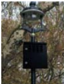
Figura 4.49 Ejemplo de router inalámbrico comercial (Cisco 3200) para proporcionar conexión WiFi a los vehículos.
